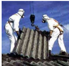
Imagem 1: Retirada de telhas compostas de amianto Fonte:UNESP [12].
